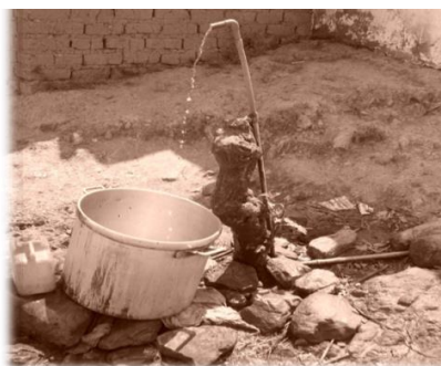
Foto N° 5. Distribución de agua antes del proyecto
