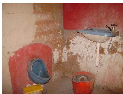
Foto N° 8. Con el proyecto, baños ecológicos y junto a la vivienda
