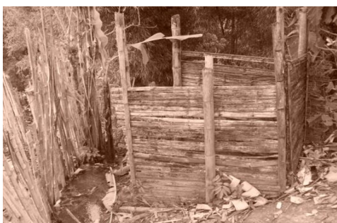
Foto N° 7. Servicios higiénicos antes del proyecto
